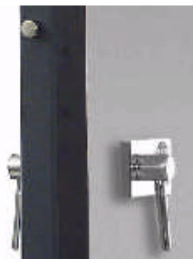
Ansicht von außen
